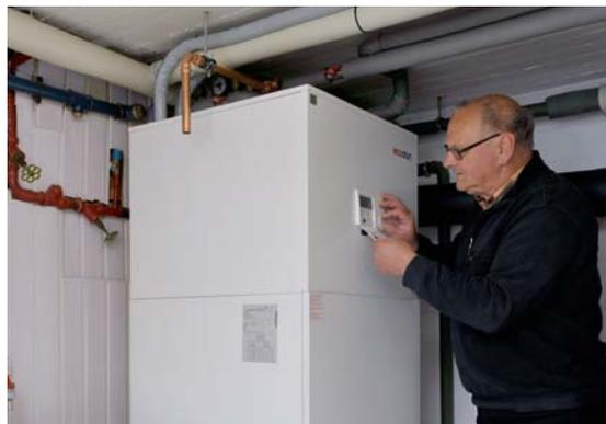
Installiert wurde ein Ecodan-Komplettsystem EH-S20-HRP112V mit 11,2 kW.
